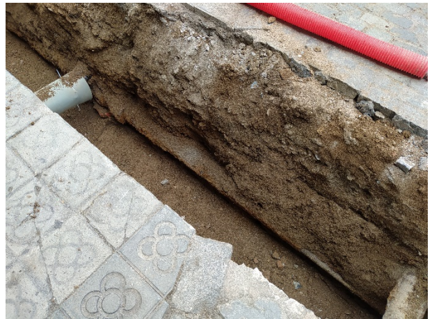
4. Rasa amb el tub antic d'aigua UE 03 a la dreta.
