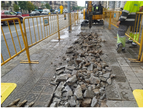
1. Aixecament del paviment UE 01.
