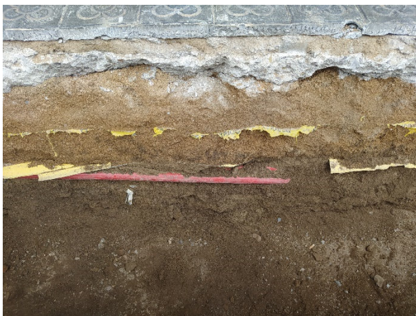
5. Cablejat elèctric UE 09.
