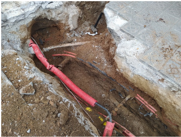
7. Cablejat elèctric UE 09 i tub per al gas UE 06 girant cap a l'oest a l'alçada del Carrer de la Duana.
