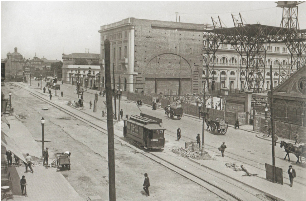
Imatge de la construcció de l'estació a partir de 1922.
