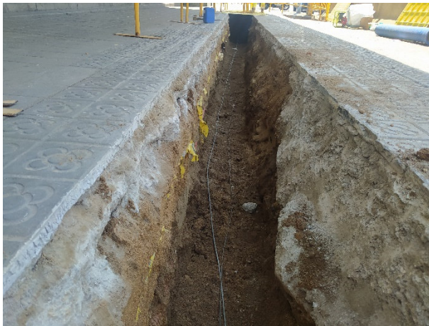
3. Vista de la rasa amb el cablejat elèctric UE 09 a l'esquerra.
