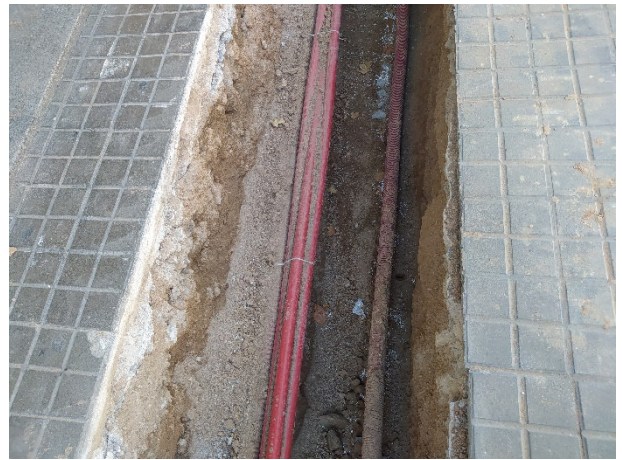
8. Cablejat UE 09 ocupant part de la rasa.
