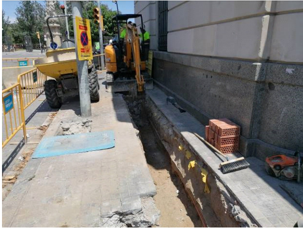
13. Tram de rasa a tocar de l'Avinguda Circumval·lació.
