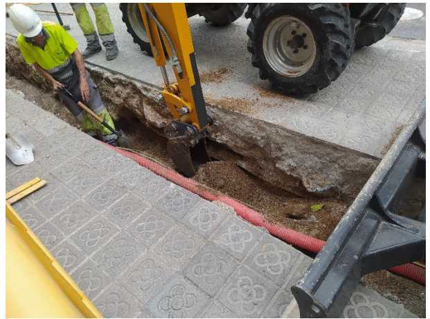
2. Extracció mecànica de les terres.
